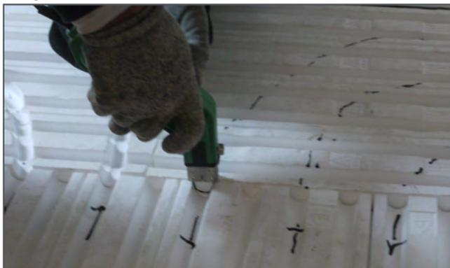
Préparer la pose du tube dans les endroits nécessitant de creuser des rainures, tels que les longueurs de passage, à l'aide du fer chaud équipé d'une lame à gorge.
