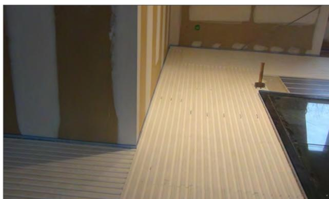
Les dalles de guidages sont utilisées soit pour les longueurs de passage des circuits, soit pour combler la surface de plancher non recouverte par les dalles intermédiaires ou les dalles de têtes.
