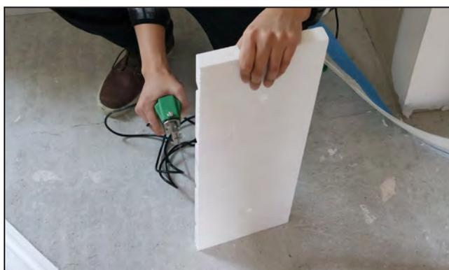
Avant de fixer les dalles au support, leurs bordures PSE doivent être ébarbées à l'aide d'un fer chaud ou d'un cutter afin d'éviter des espacements. Les bordures de découpe aluminium doivent être limées à l'aide d'une lime afin de ne pas endommager les tubes.
