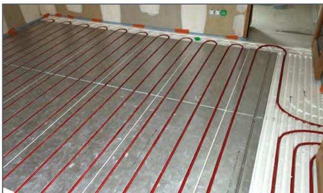
Dérouler le tube en épingle, et raccorder l'aller et retour au collecteur. Dans les zones de demi-tours, le tube est enfoncé dans les rainures des dalles de têtes afin d'être correctement maintenu en position.
