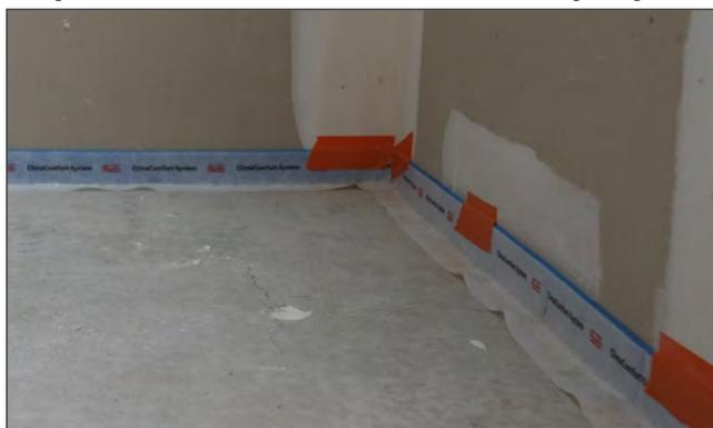
La bande d'isolation périphérique est posée le long de tous les murs et de tous les éléments verticaux présents sur la surface à revêtir du système ROTH ClimaComfort® Panel. Si besoin, fixer la bande au mur à l'aide de ruban adhésif ou d'agrafes muraux
